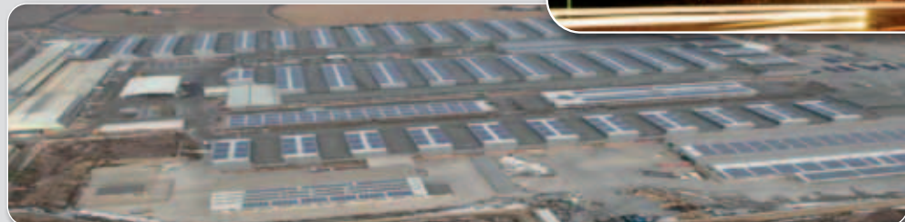
Impianto FV da 2,8 MWp integrato su coperture (AL)
